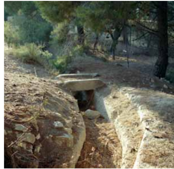
9 Tramo original del Riego Mayor del Alfaz.
